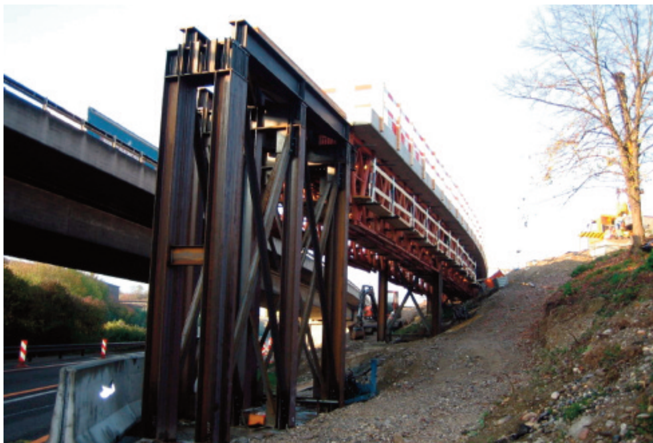
Montage du pont provisoire à l'échangeur d'Augst, octobre 2005
