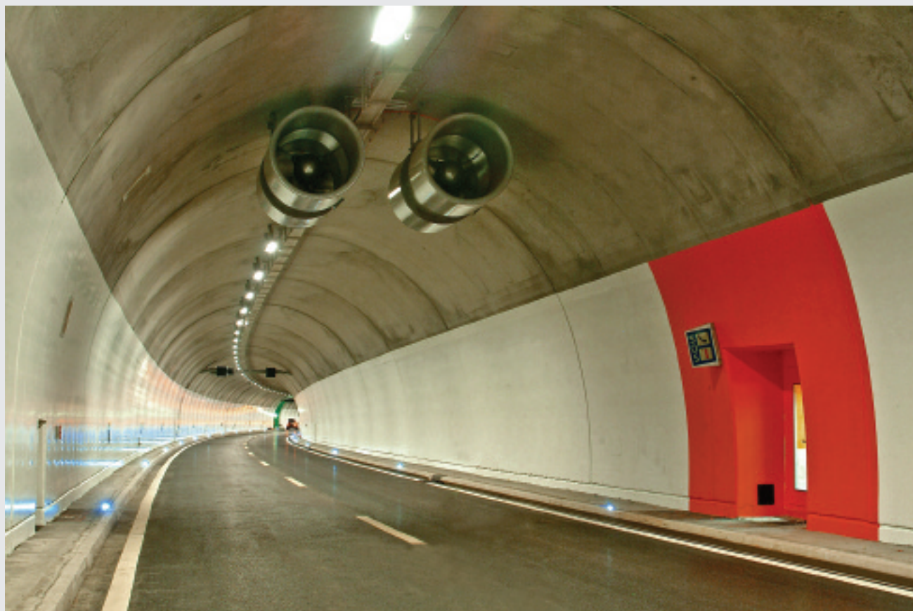
Le tunnel de Gion, terminé en 2005
