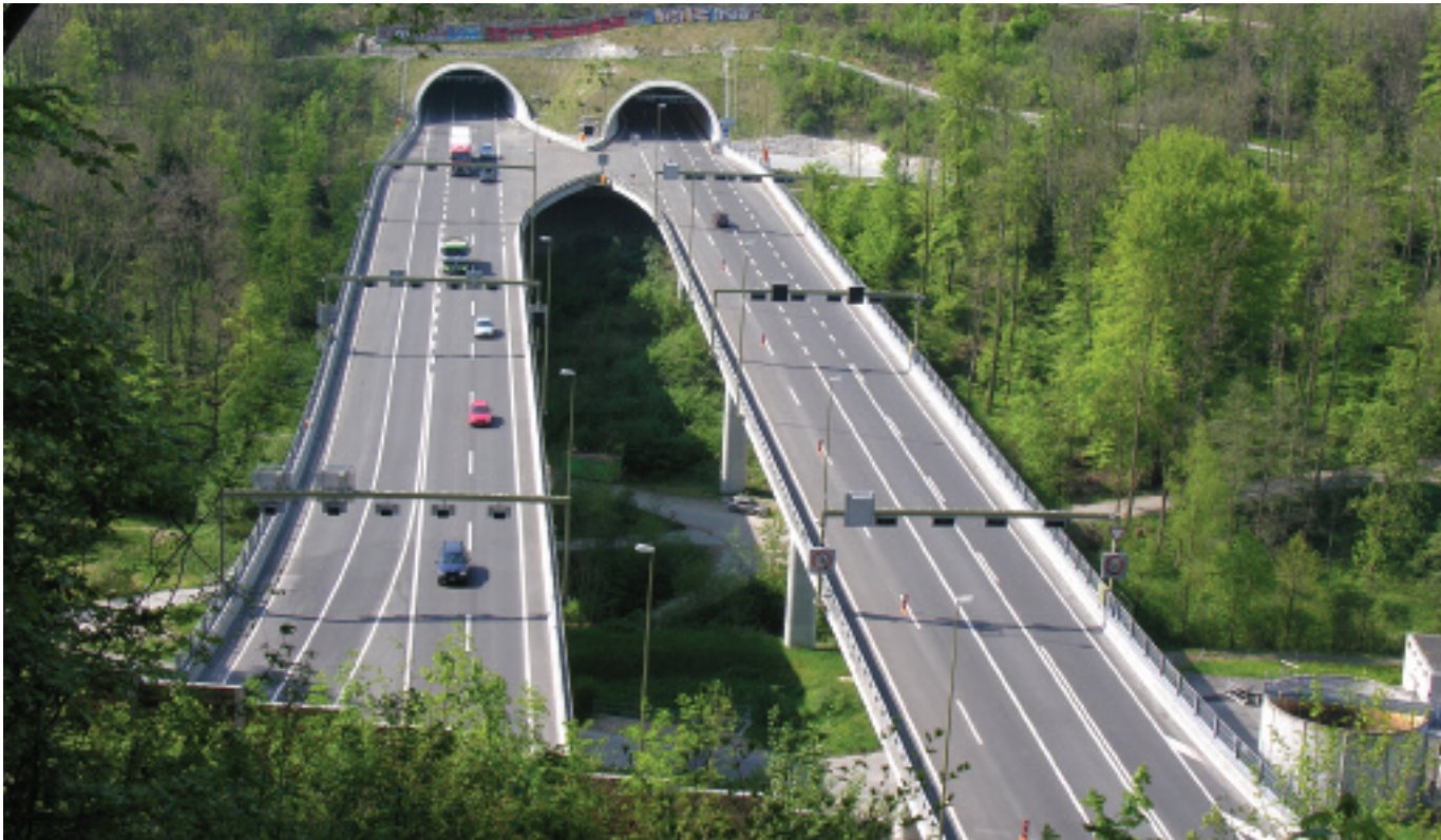
Pont de Reppischtal à Urdorf
