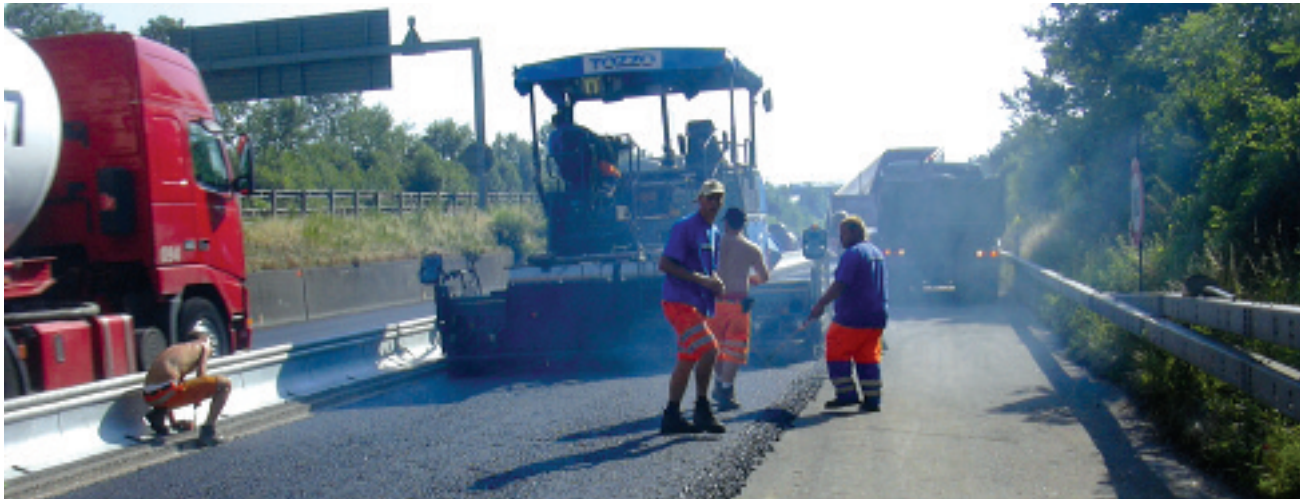
Pose du revêtement sur l'A2 Bâle-Augst
